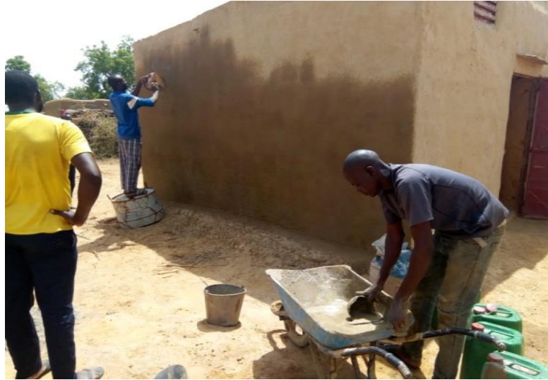
Photo : Finition travaux construction cuisine de Soguina
